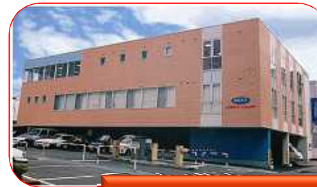
シダー本社ビル
